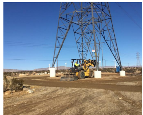
Construcción de torres
