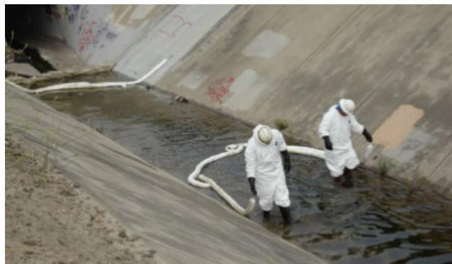
Limpieza de derrames en un canal
