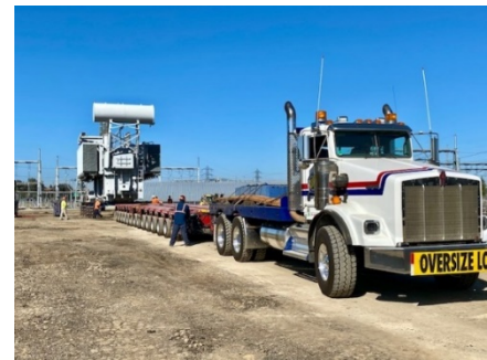
Instalación de un transformador
