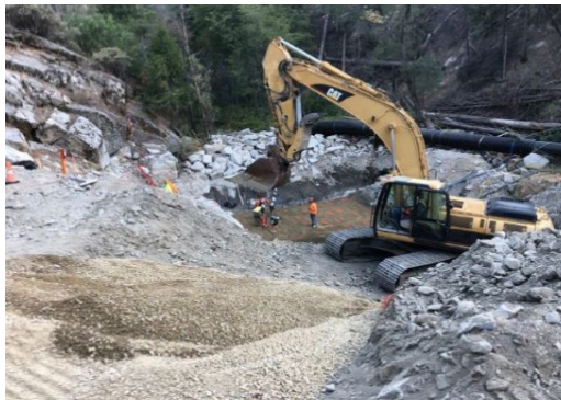
Instalación y compactación de roca base permeable
