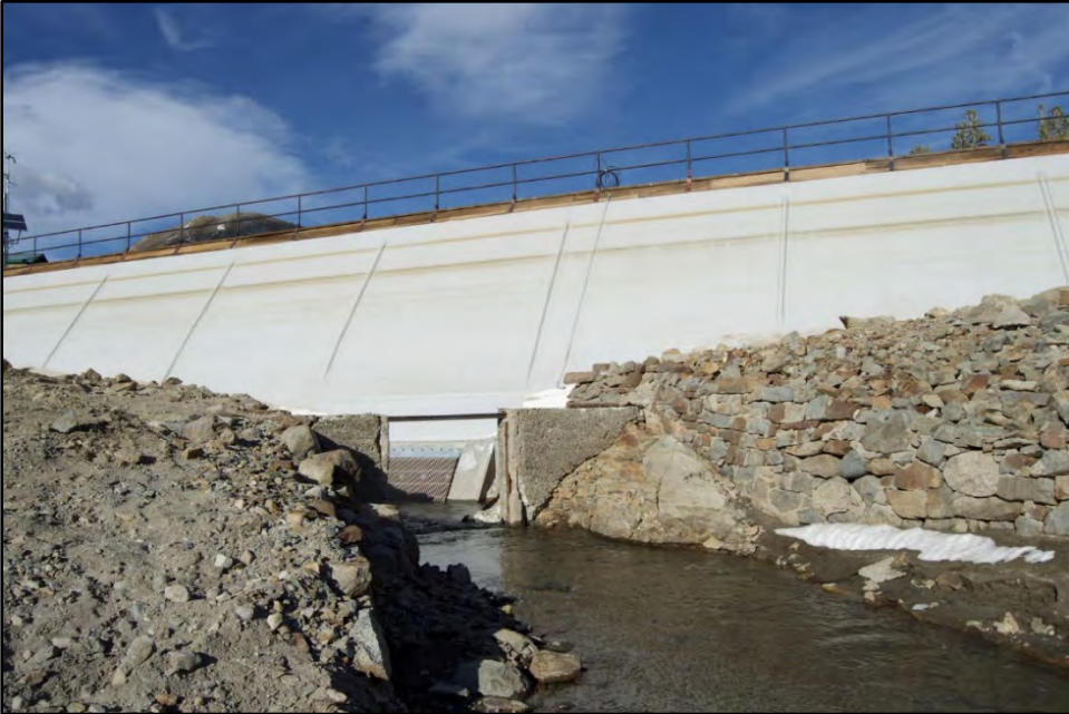
Photo 4. Tioga Dam Outlet.
