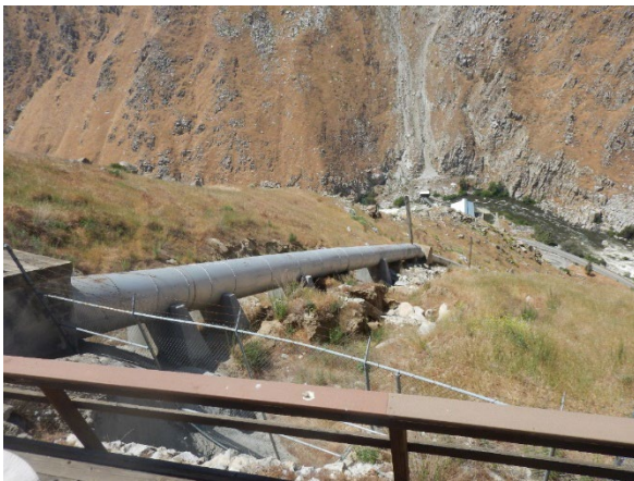
Forebay Spillway Pipe
