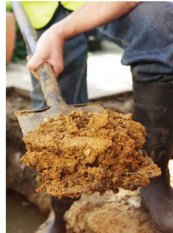
Luego de llamar a Dig Alert, personal de SCE irá hasta el sitio para señalarle el recorrido del gasoducto. Si desea cavar cerca de un gasoducto de propano, utilice herramientas de mano hasta encontrar el tubo.
